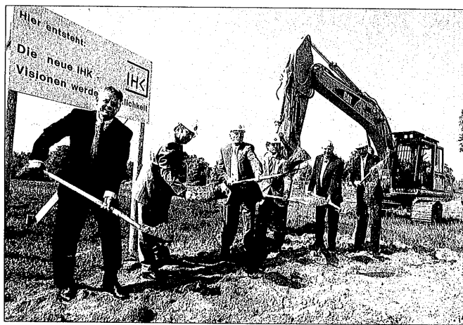
Ja, ja, ja, jetzt wird wieder in die Hände gespuckt: Heinrich Metzger, Wolfgang Memminger, Günter Steffen, Peter Koch, Architekt Michael Weindel und OB Helmut Himmelsbach beim ersten Spatenstich (Foto: Monika Scheffler)
