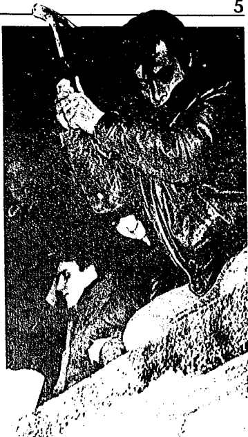
Oben: Mit dem Hammer gegen die Mauer - die Öffnung der innerdeutschen Grenze in Berlin war diesem jungen Mann nicht genug. Sainer Froude gab er mit einem symbolischen Beginn der Abbrucharbeiten Ausdruck. Foto unten: Hilfsbereite Hände streckten sich hüben und drüben denen entgegen, die über die Mauer kletterten
